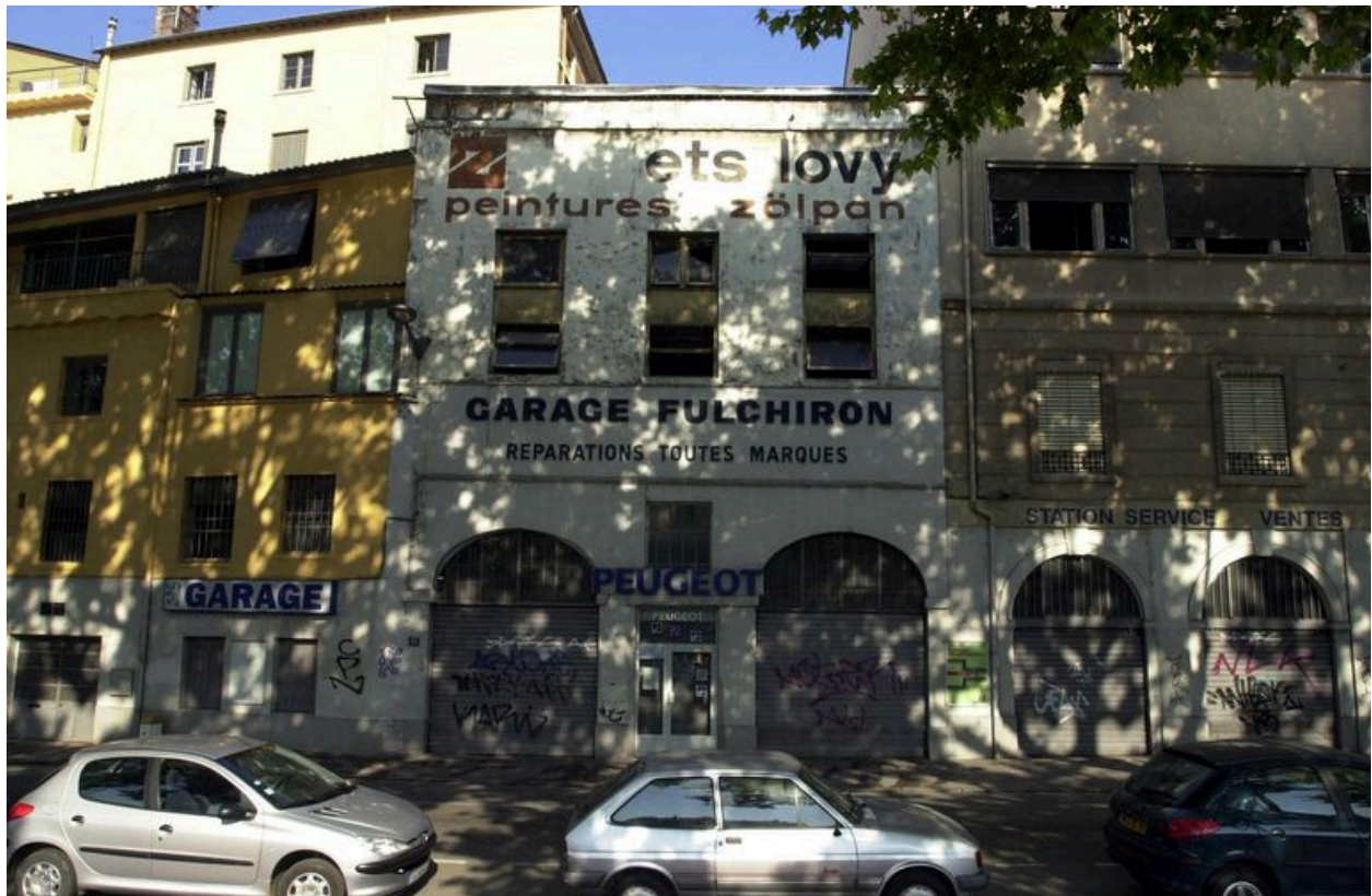
Vue générale de la façade sur le quai
