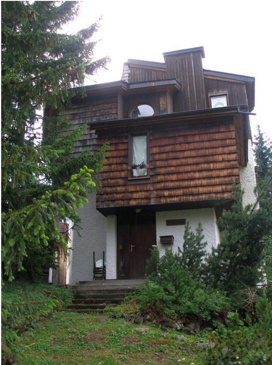
Vue d'ensemble de la façade est
