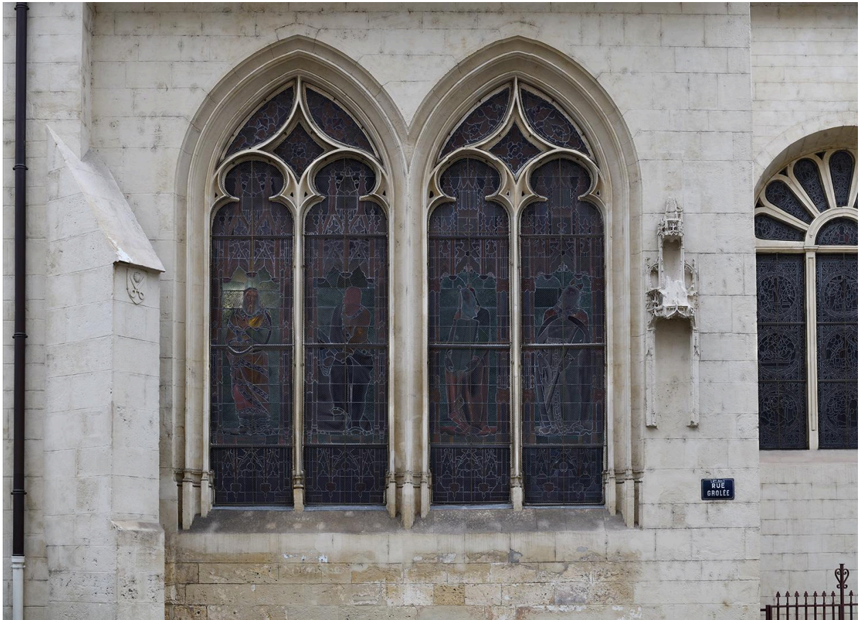
Elévation ouest, baie 8
