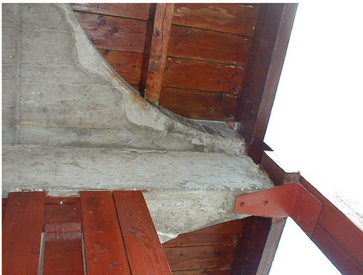
Les terrasses : détail de construction bois-béton
