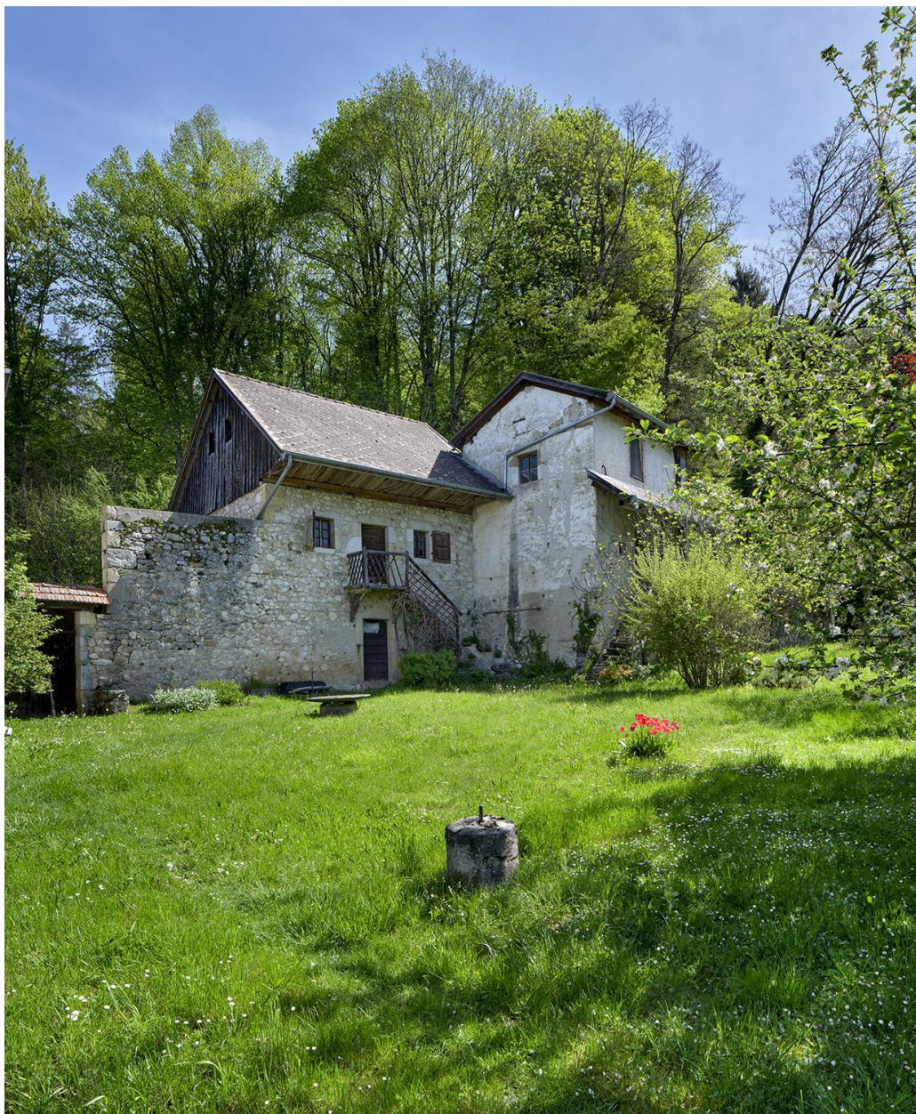
Vue d'ensemble des deux bâtiments situés au nord-est du corps de logis (le grenier et le pigeonnier).
