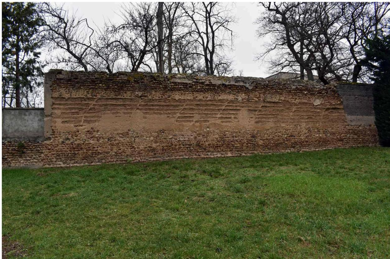
Ancien mur en moellons et pisé, entre le logement de fontion D et les serres
