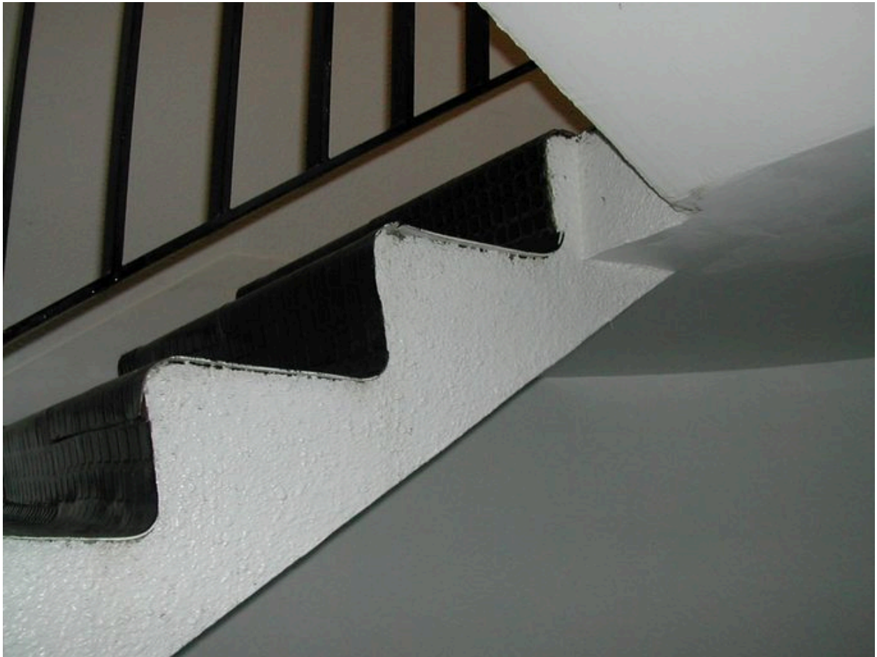
Escalier. Détail des marches
