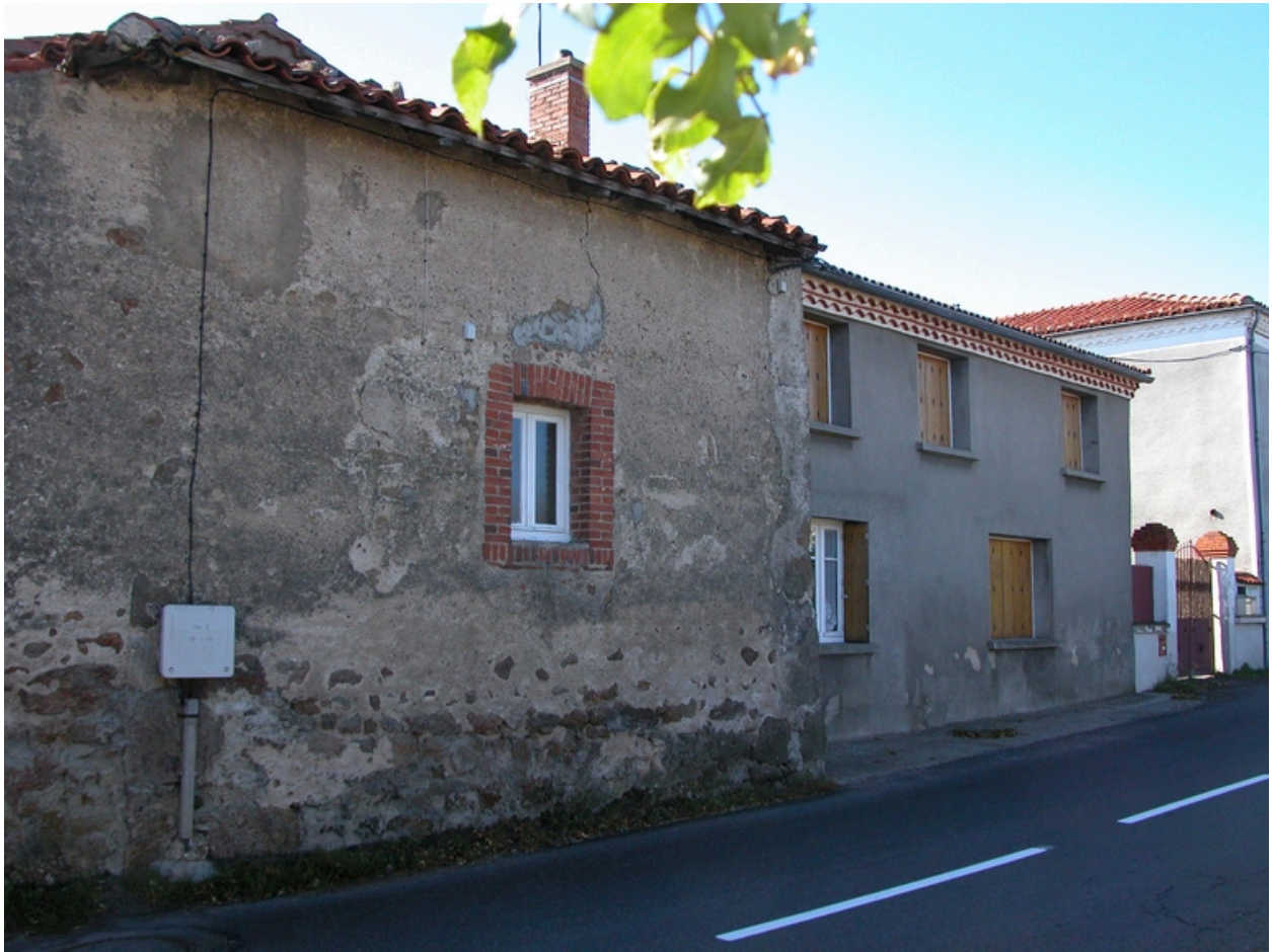
Café et ferme à Faury (non repéré, 1986 A 2) : vue du café transformé en habitation.
