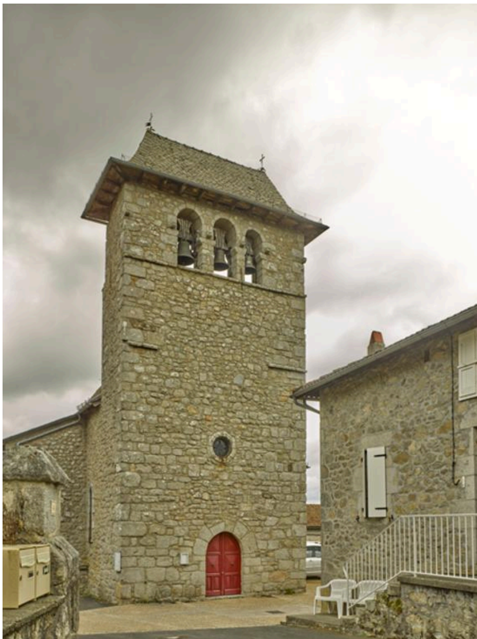
Vue de la façade occidentale
