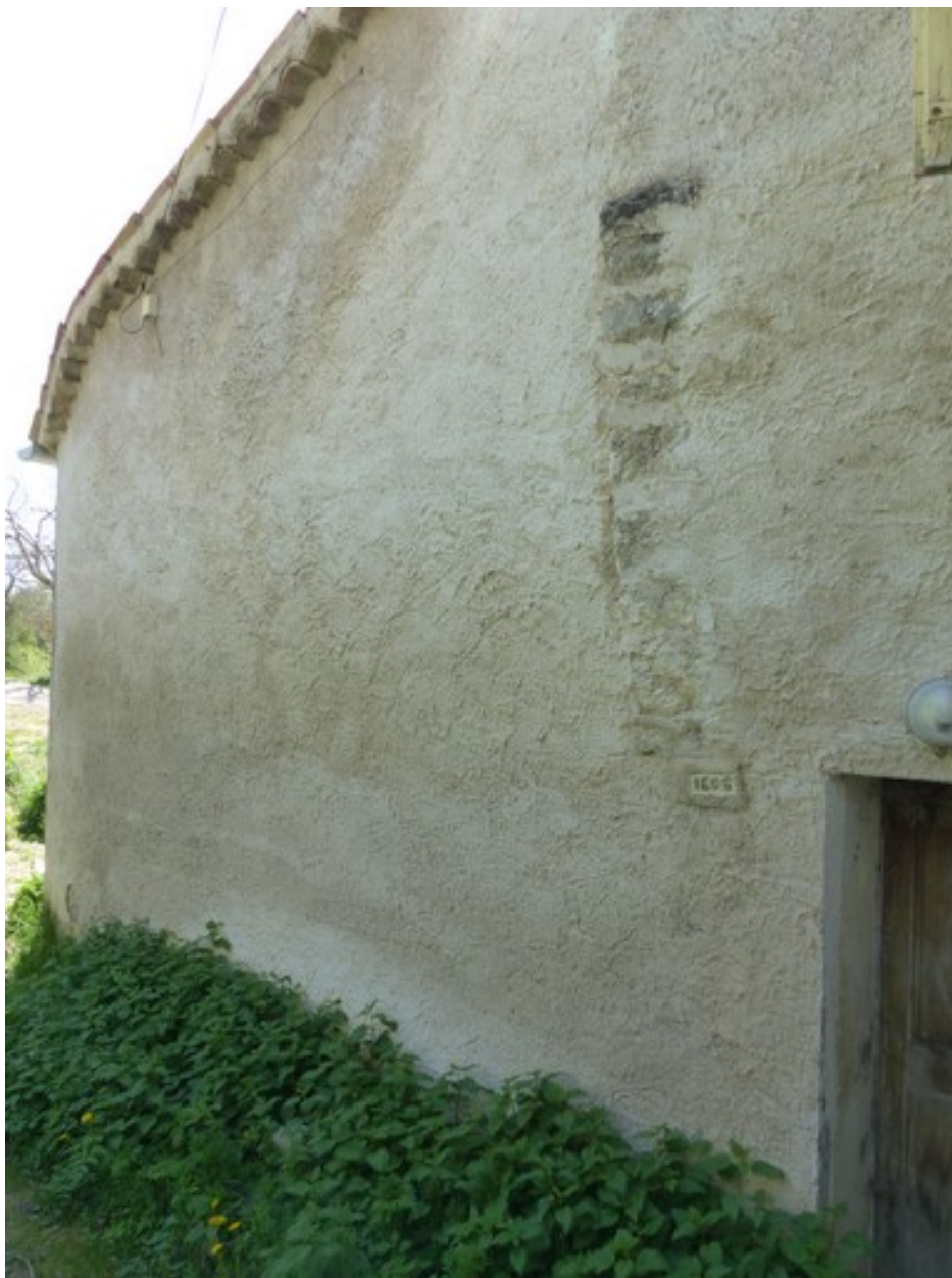
Partie est. Elévation nord.
