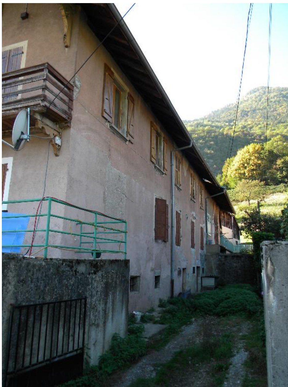
Vue de la façade nord.
