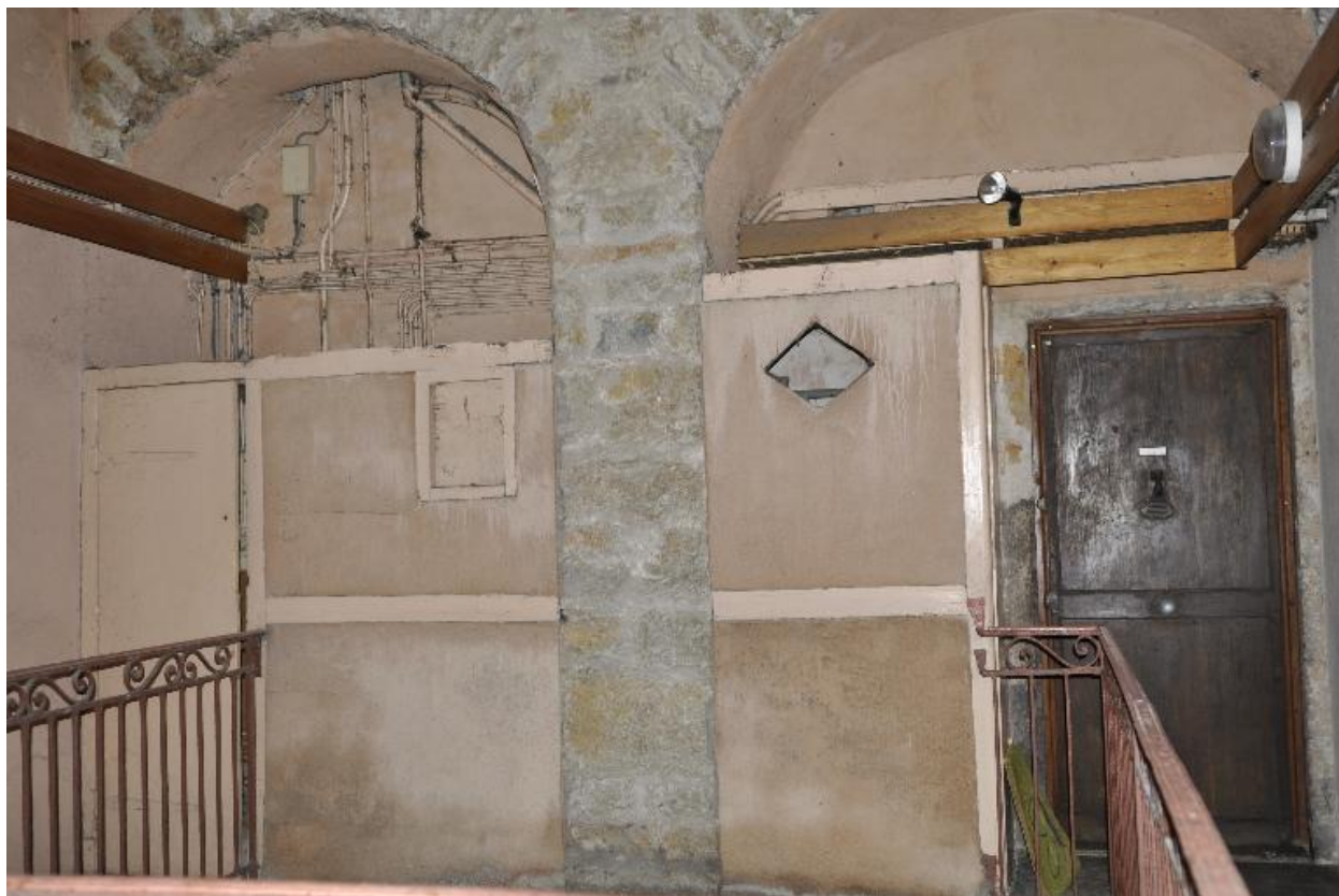
Latrines et porte d'appartement du premier étage au n°14 rue Dumenge
