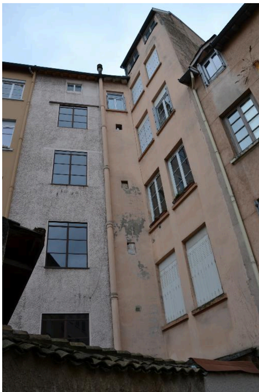
Vue d'ensemble façade nord
