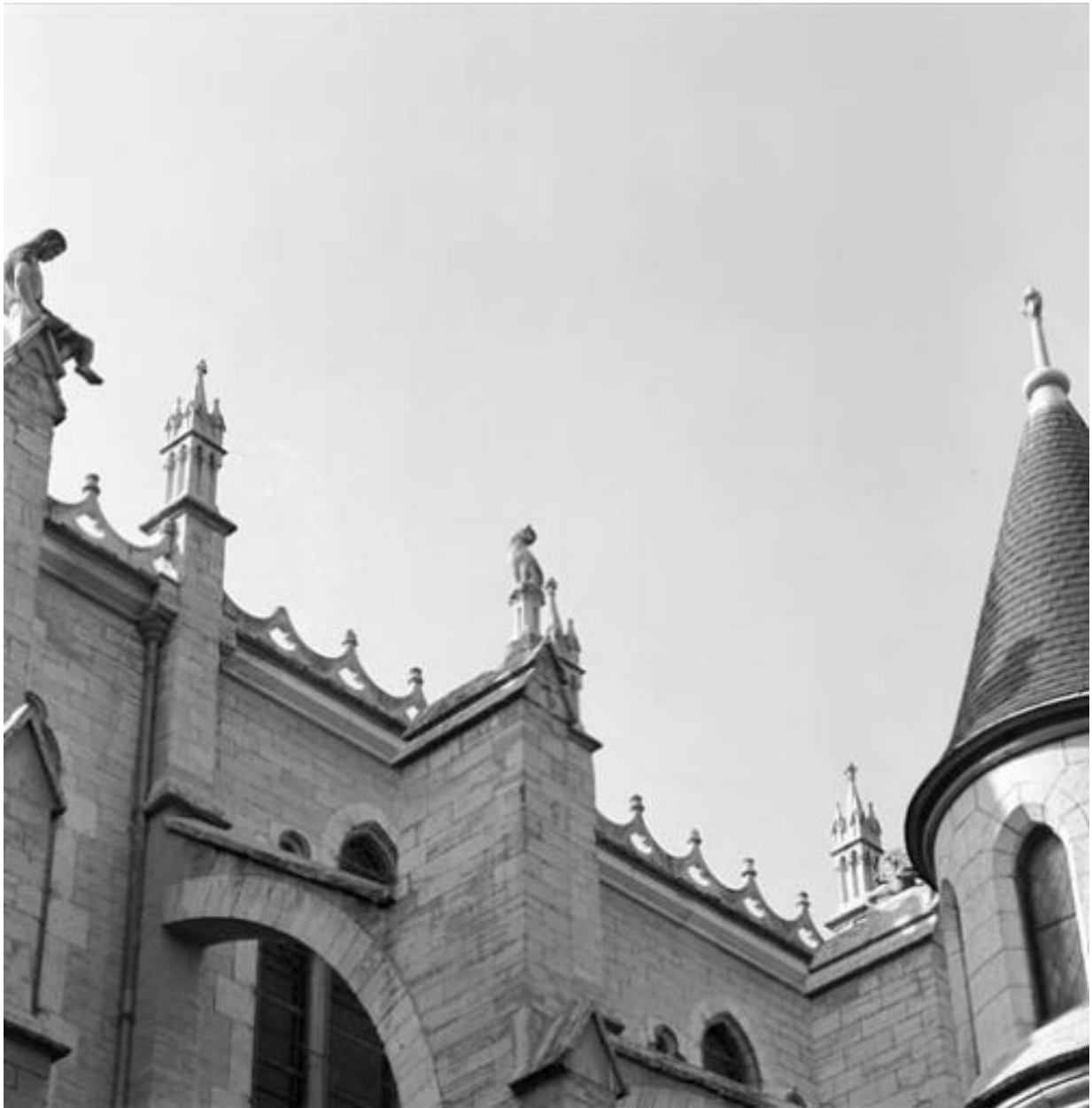
Détail de sculptures d'amortissement : élévation nord
