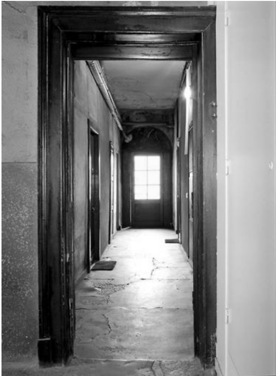
Vue d'un couloir latéral
