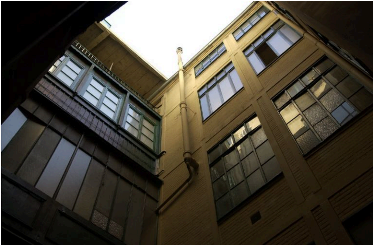
1ère cour, partie haute et coursières
