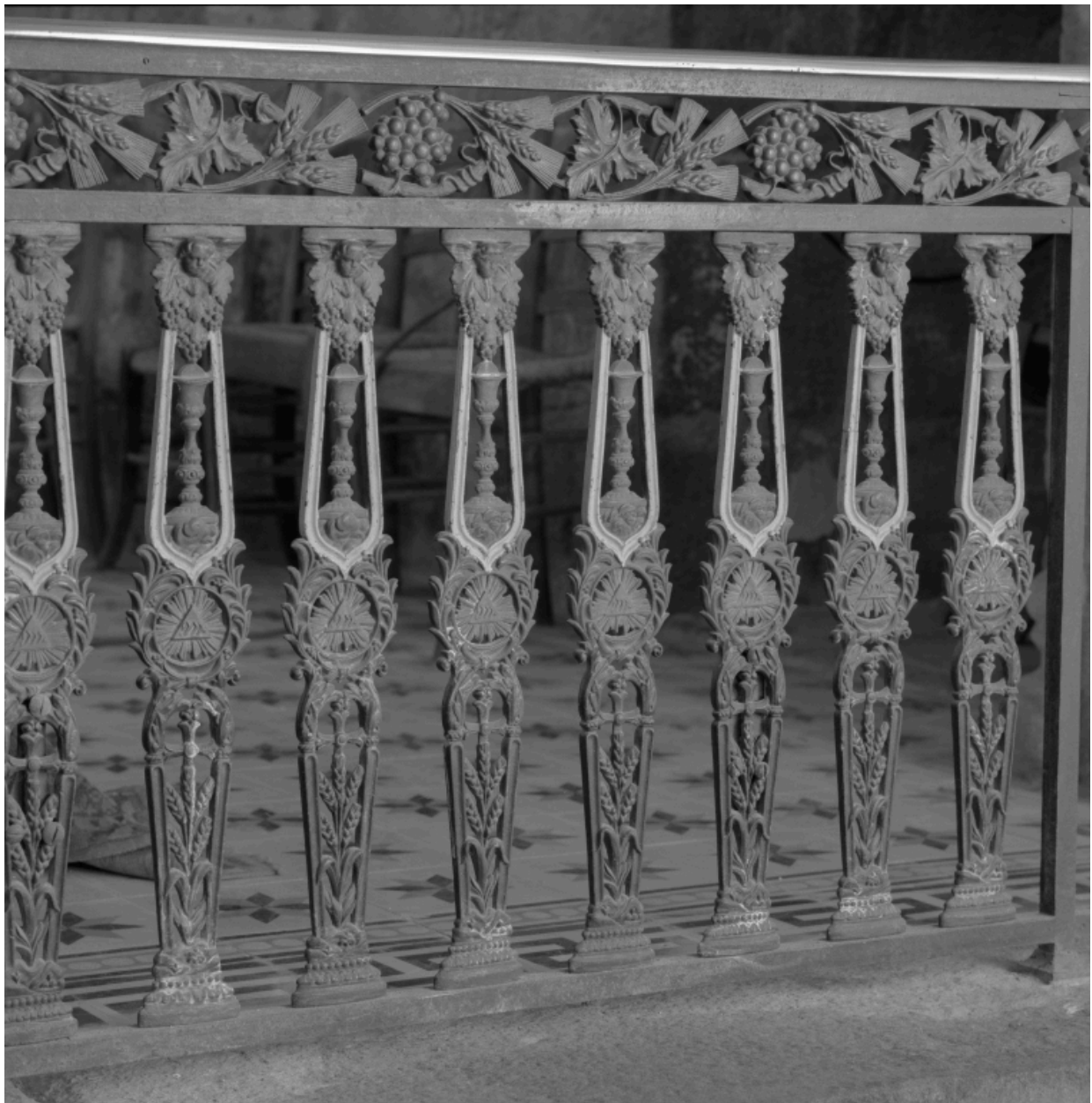
Vue d'une partie de la clôture.
