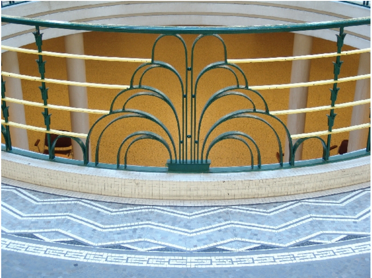
Détail des ferronneries du hall
