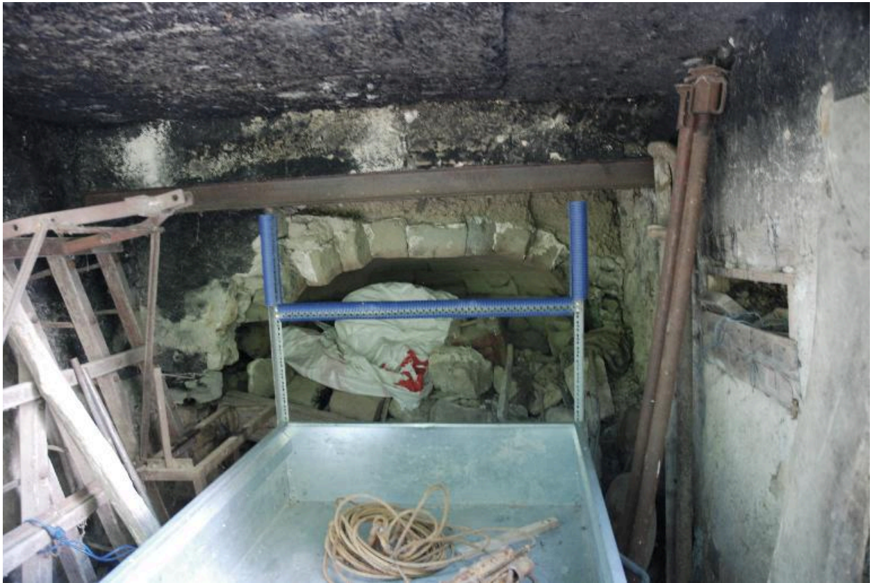
Vue partielle intérieure du four à pain.
