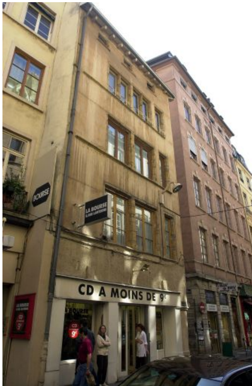
Façade sur la rue Lanterne
