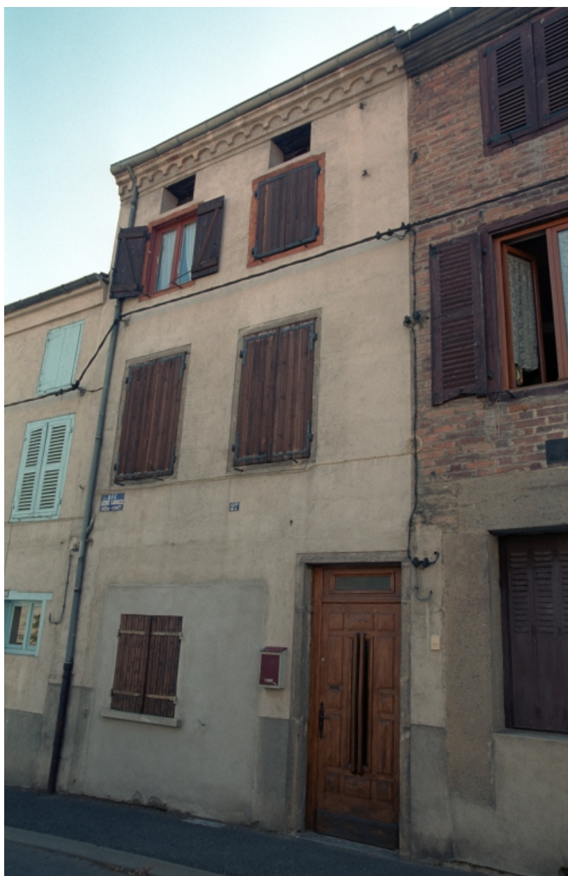
Boën, îlot 15, Gustave Labrosse (rue) 27. Vue générale de la façade sur rue.
