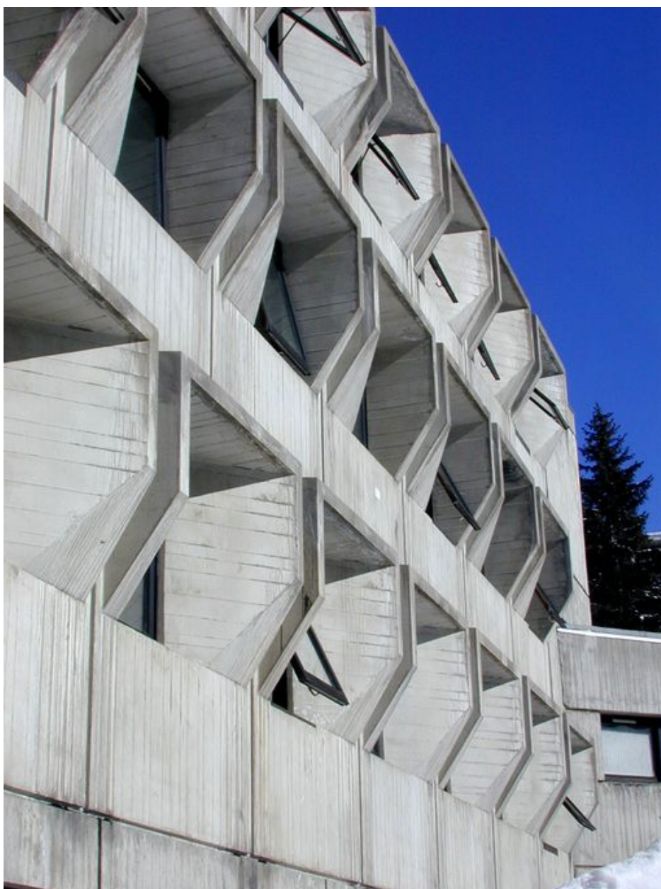
Etat avant réfection. Façade sud. Détail des baies
