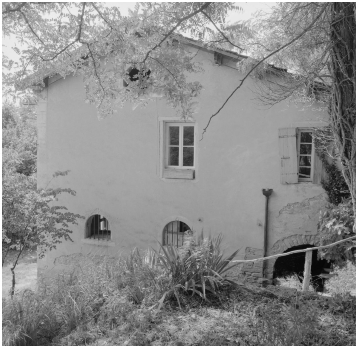
Aile nord, élévation latérale est : mur pignon.
