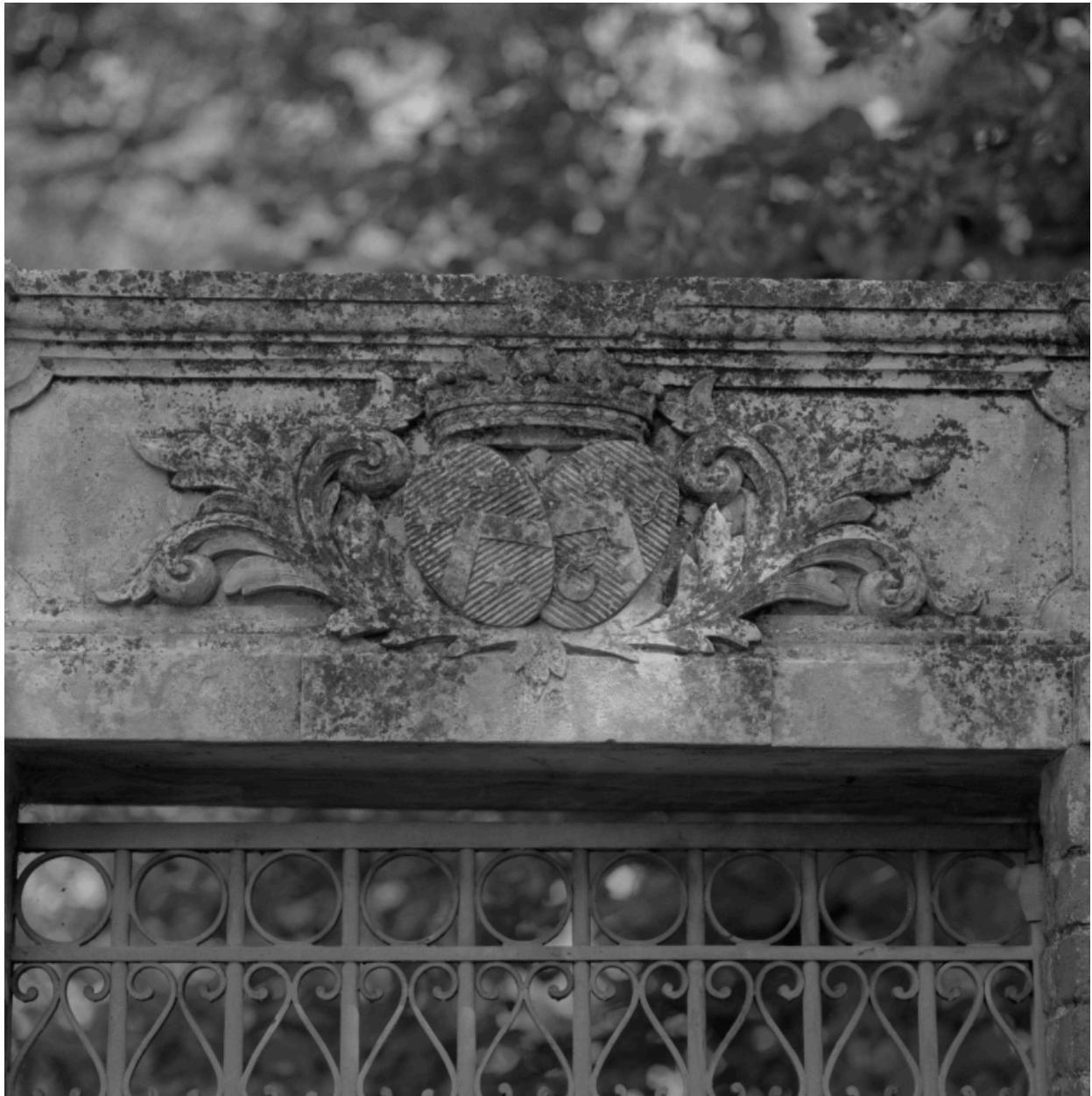
Détail des armoiries sculptées sur le linteau de la porte piétonne à l'entrée du domaine.
