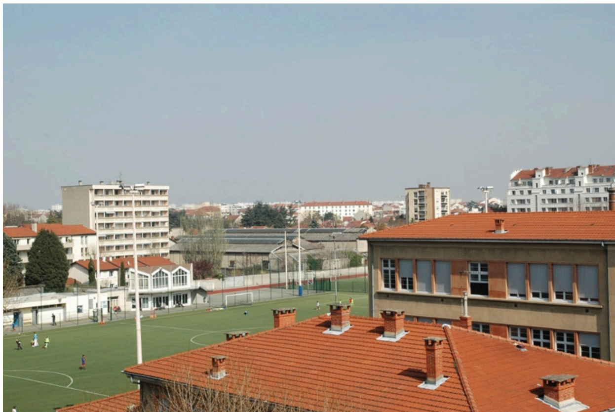
Vue d'ensemble est des ateliers
