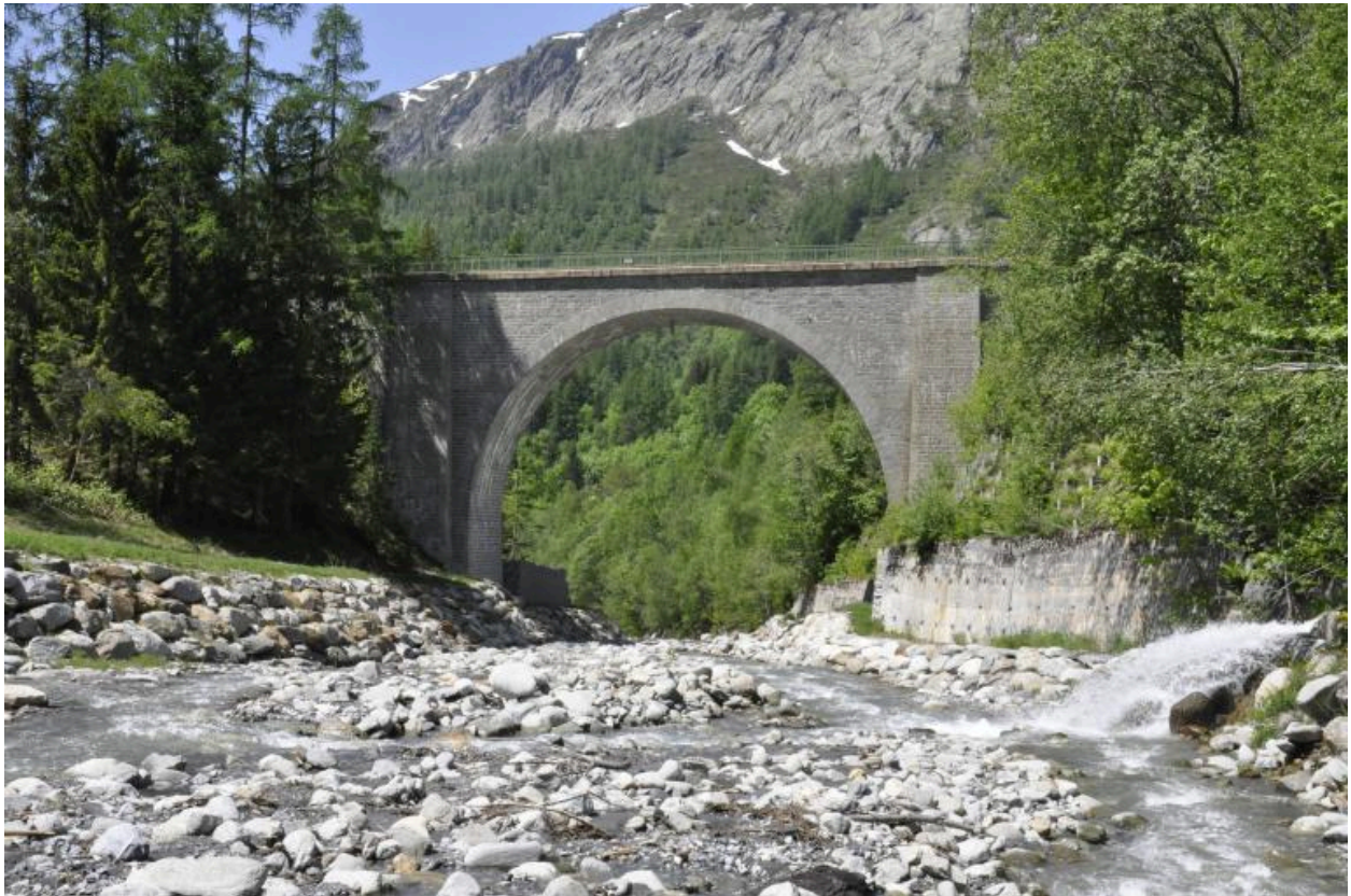
Vue de la face amont du viaduc de Mont-Roc et de son arche principale
