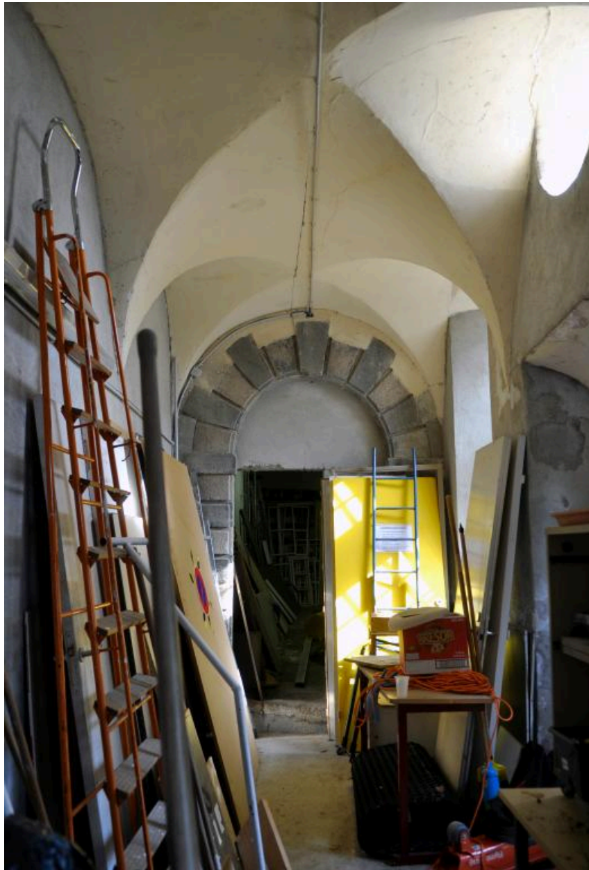
Pavillon ouest : vue de la pièce en rez-de-chaussée depuis le sud et ancienne porte communiquant avec le corps de bâtiment nord de la cour 2
