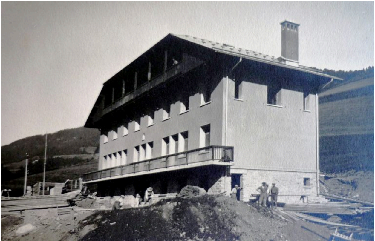
Vue d'ensemble à la fin des travaux. Photogr., [1927] (AD Haute-Savoie. 142J 439)
