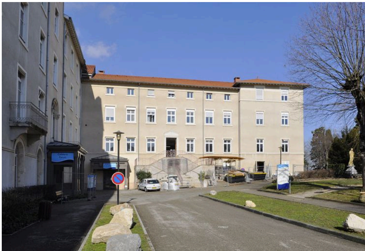
Aile C : façade sud
