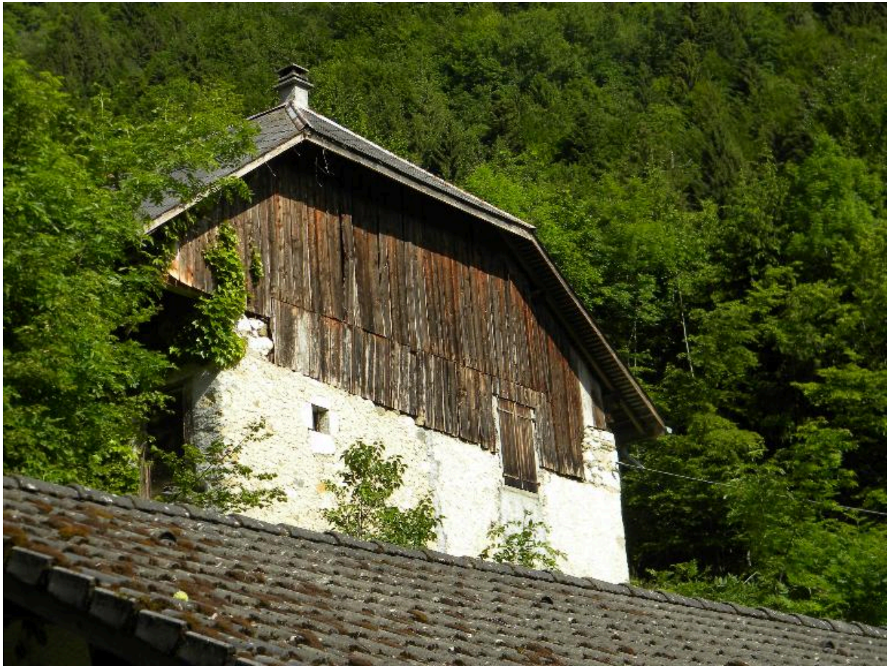
Vue d'ensemble du pignon est.
