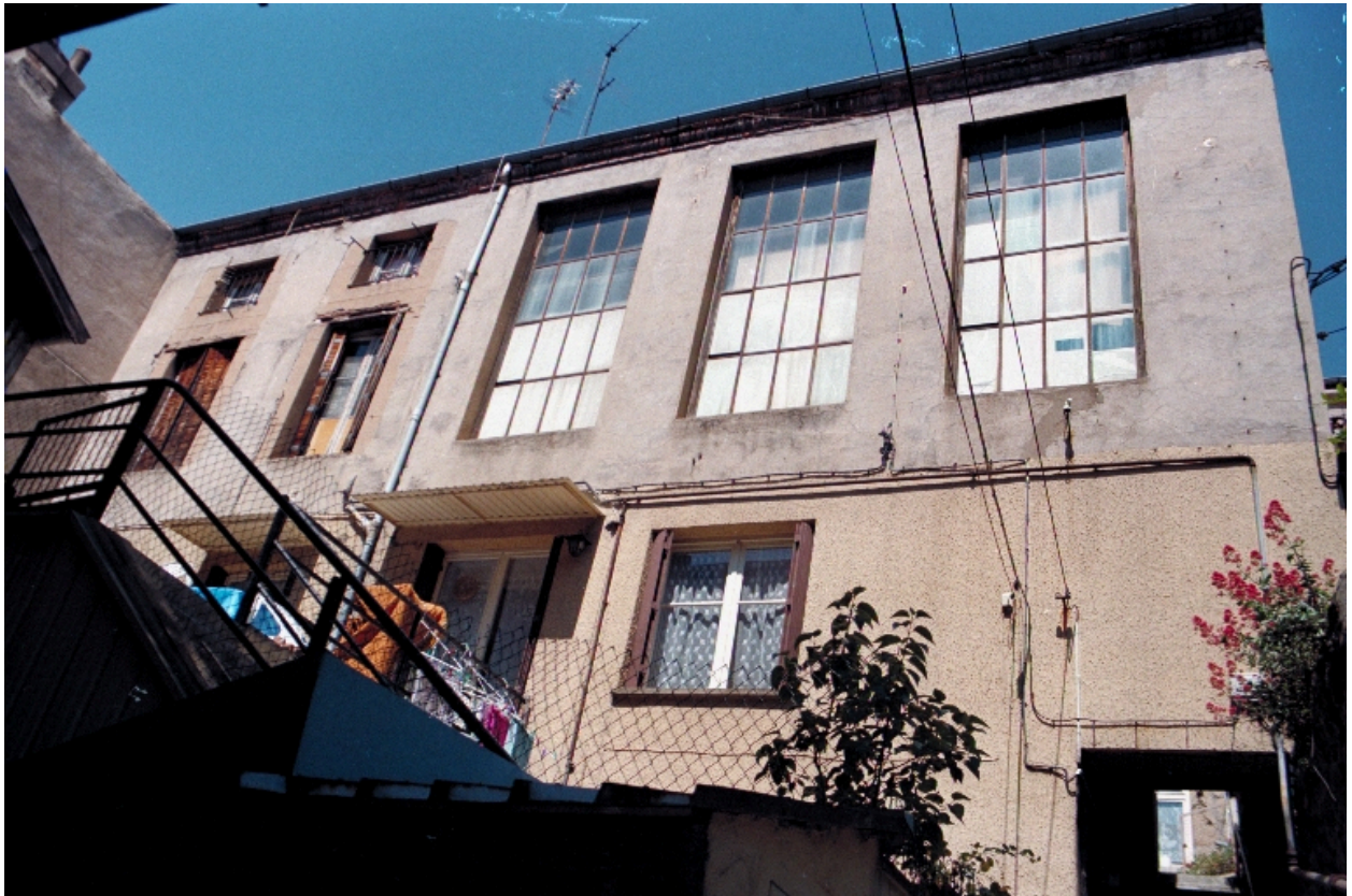
Façade principale de l'immeuble situé en milieu de parcelle
