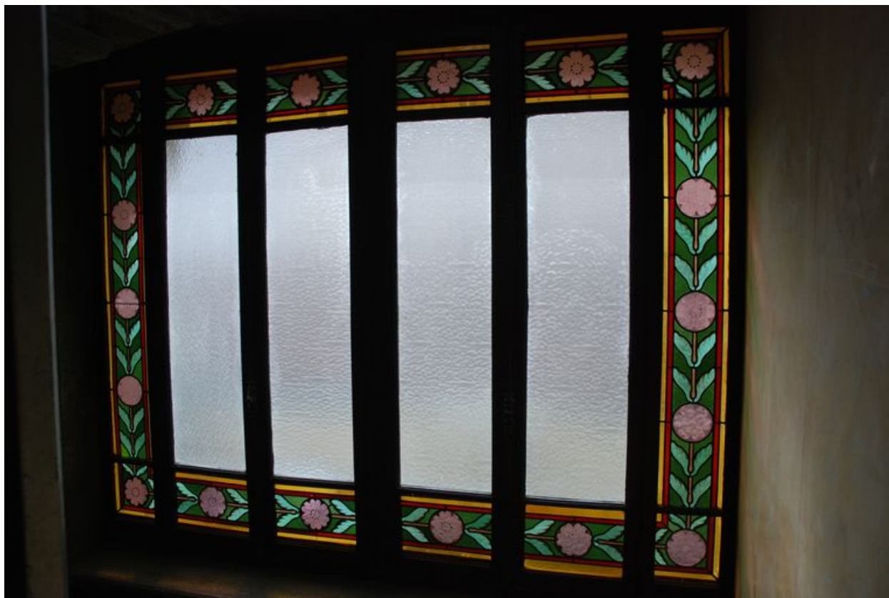
Vue d'une verrière dans la cage d'escalier
