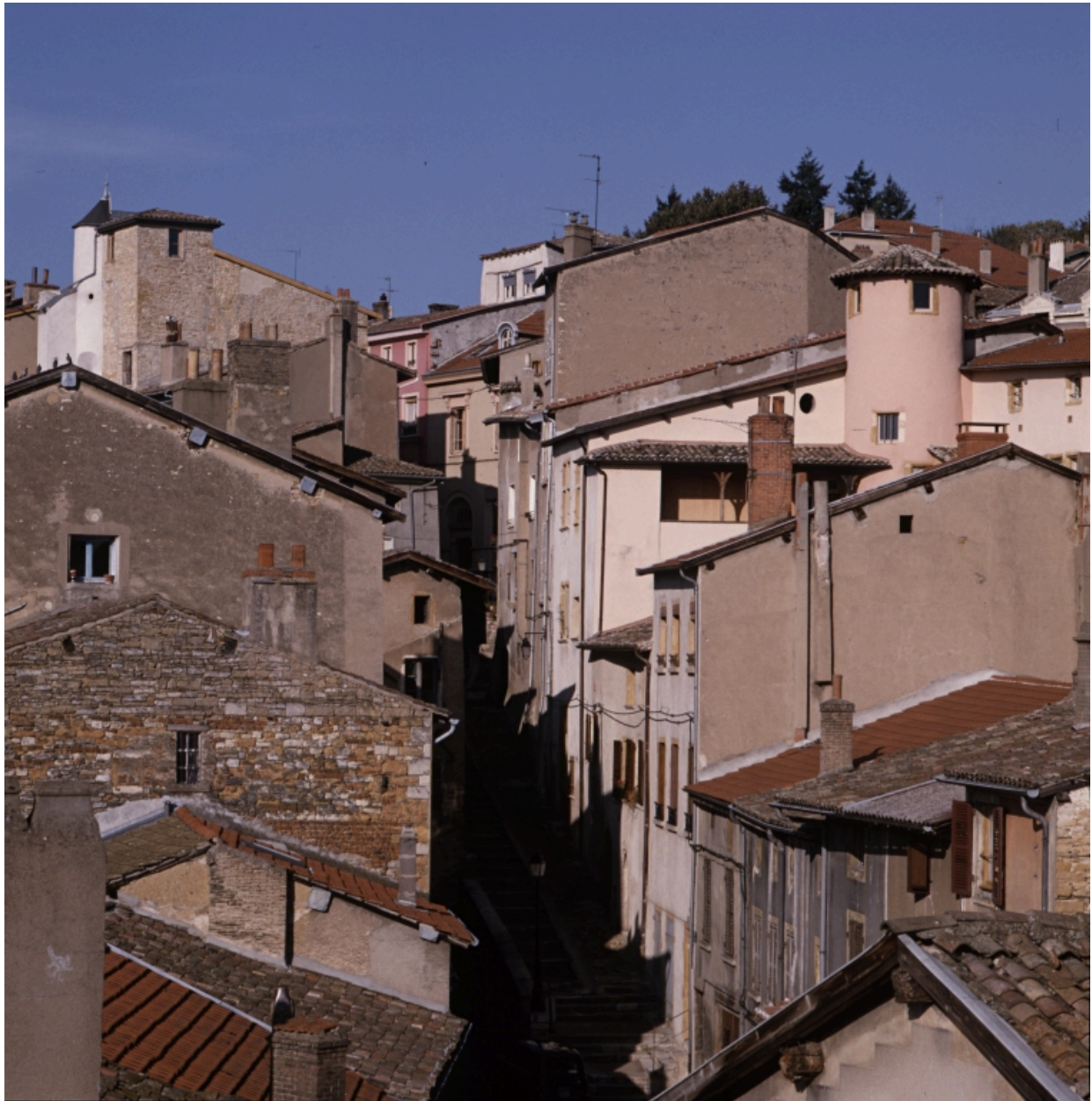
Vue d'ensemble dans l'îlot, côté rue Casse-cou (au centre, à gauche).
