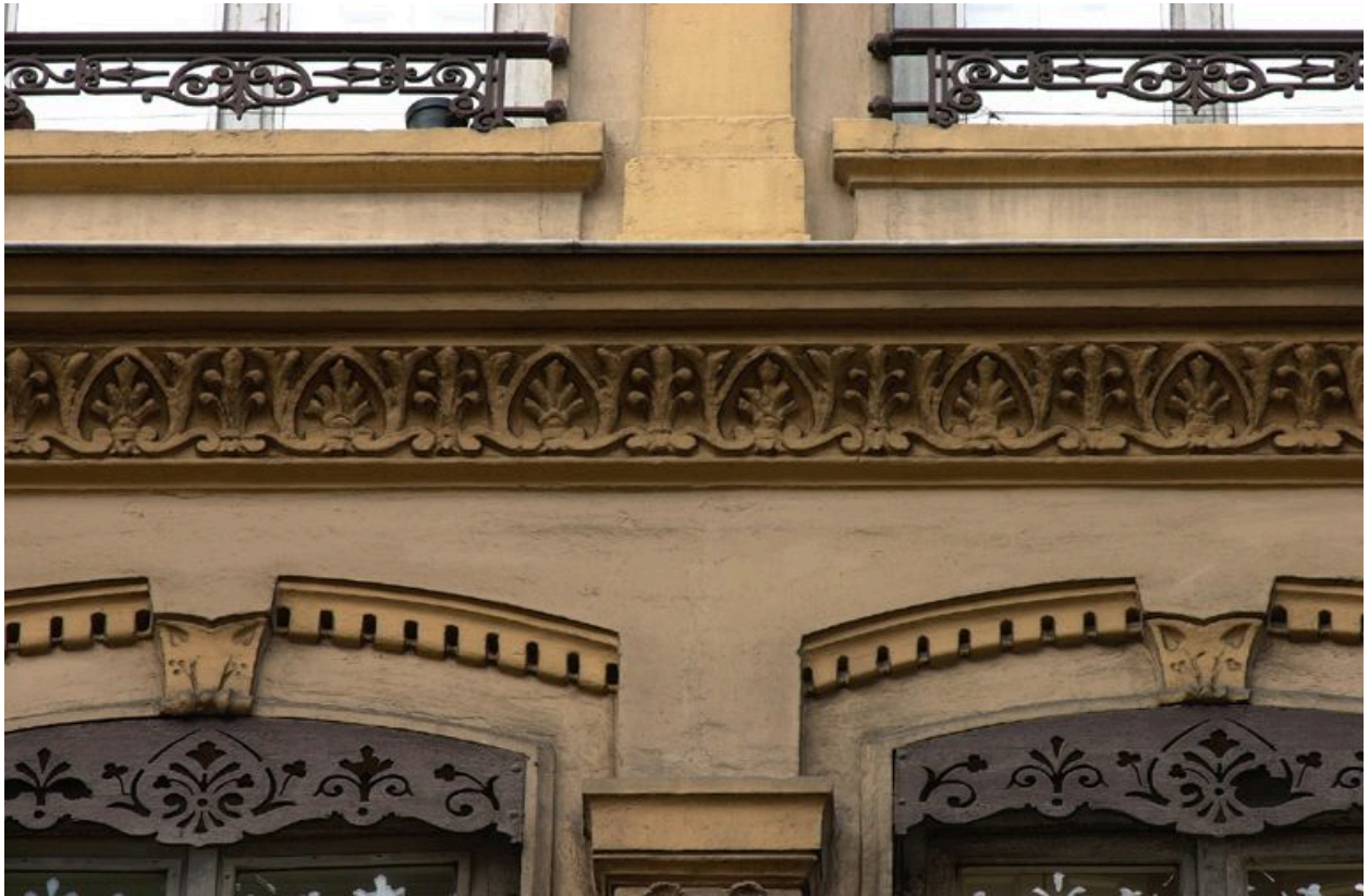
Elévation antérieure : frise ornée de motifs végétaux
