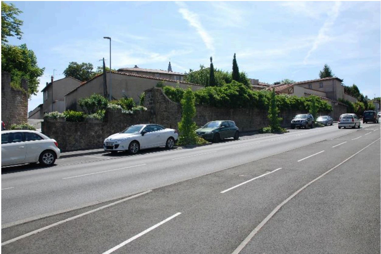
Vue générale depuis le nord-ouest et l'avenue de la Libération.
