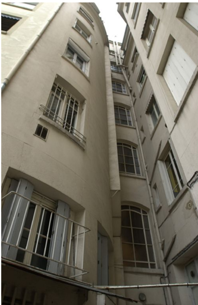
Vue du haut de la cage d'escalier depuis la cour
