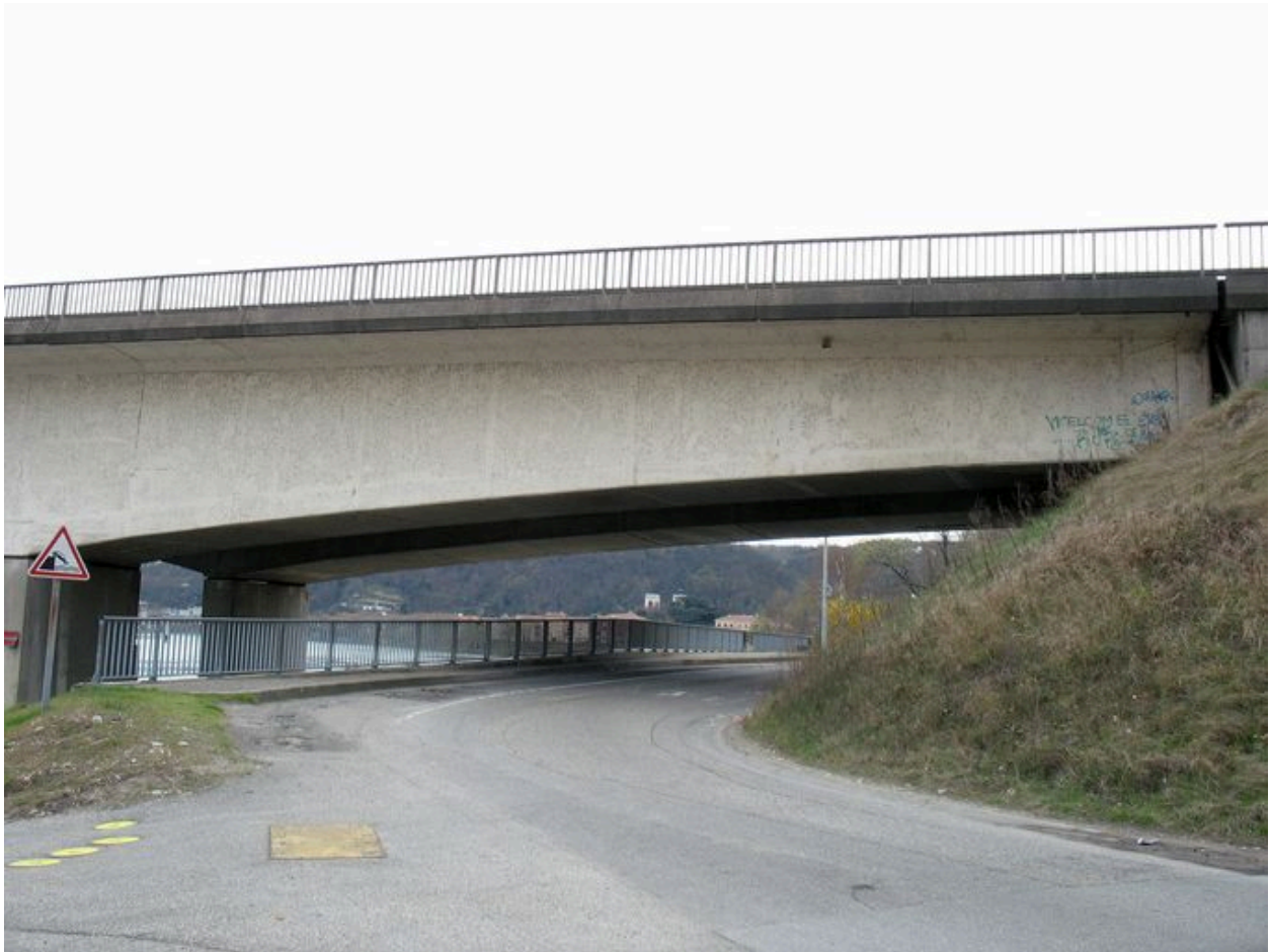
Travée de rive droite (ouest), côté amont
