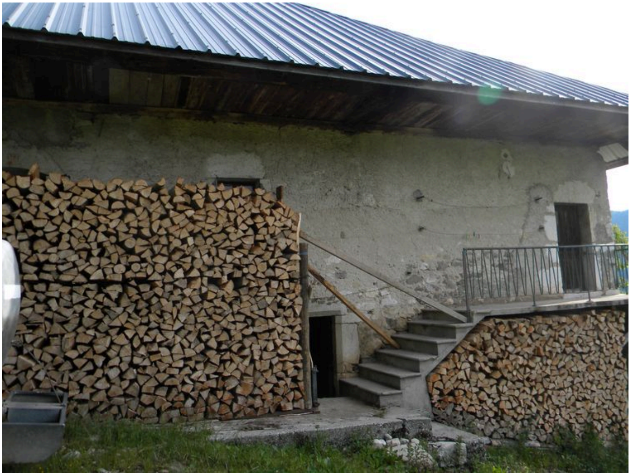
Vue de la façade sud du logis.
