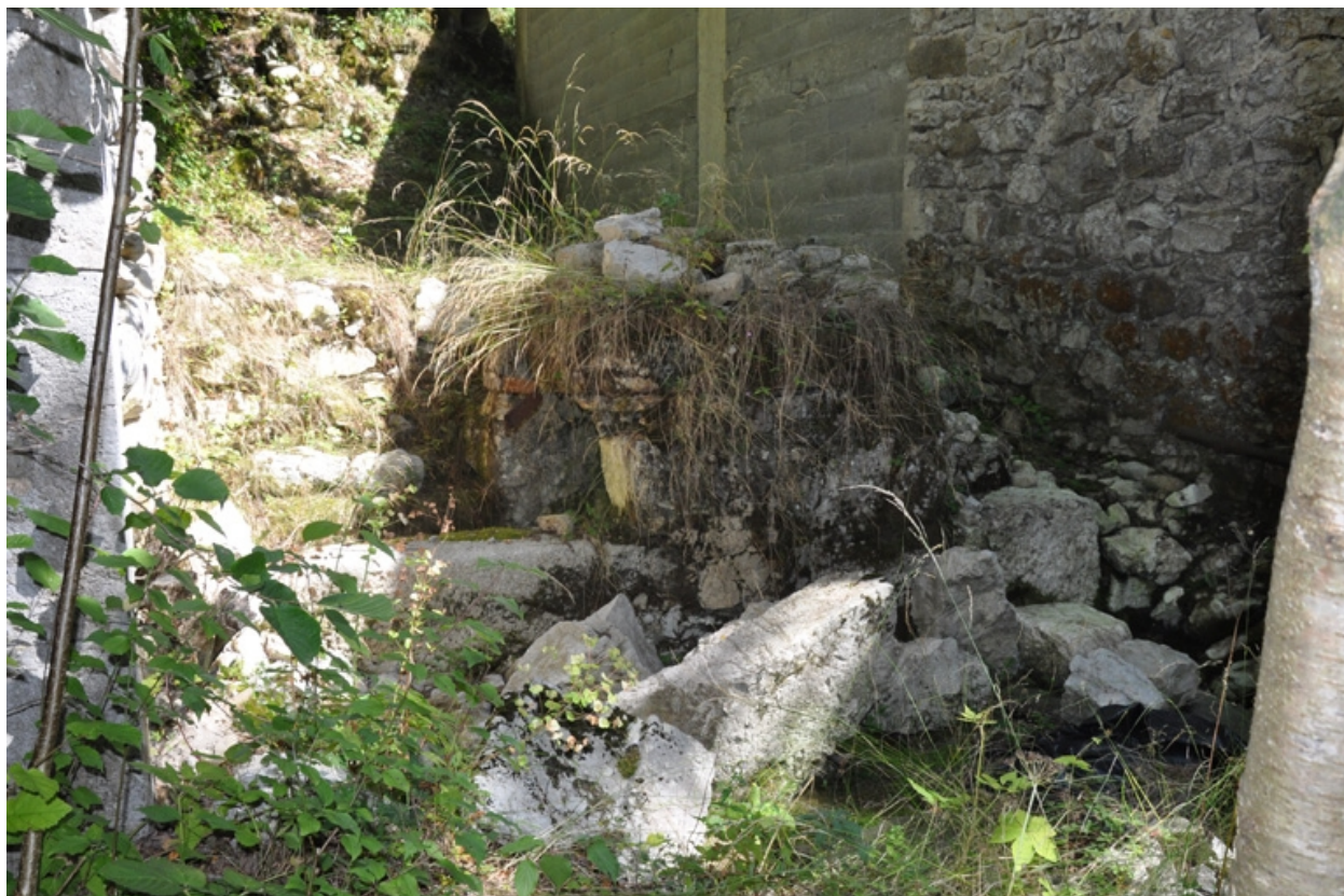
Vue des vestiges du moulin
