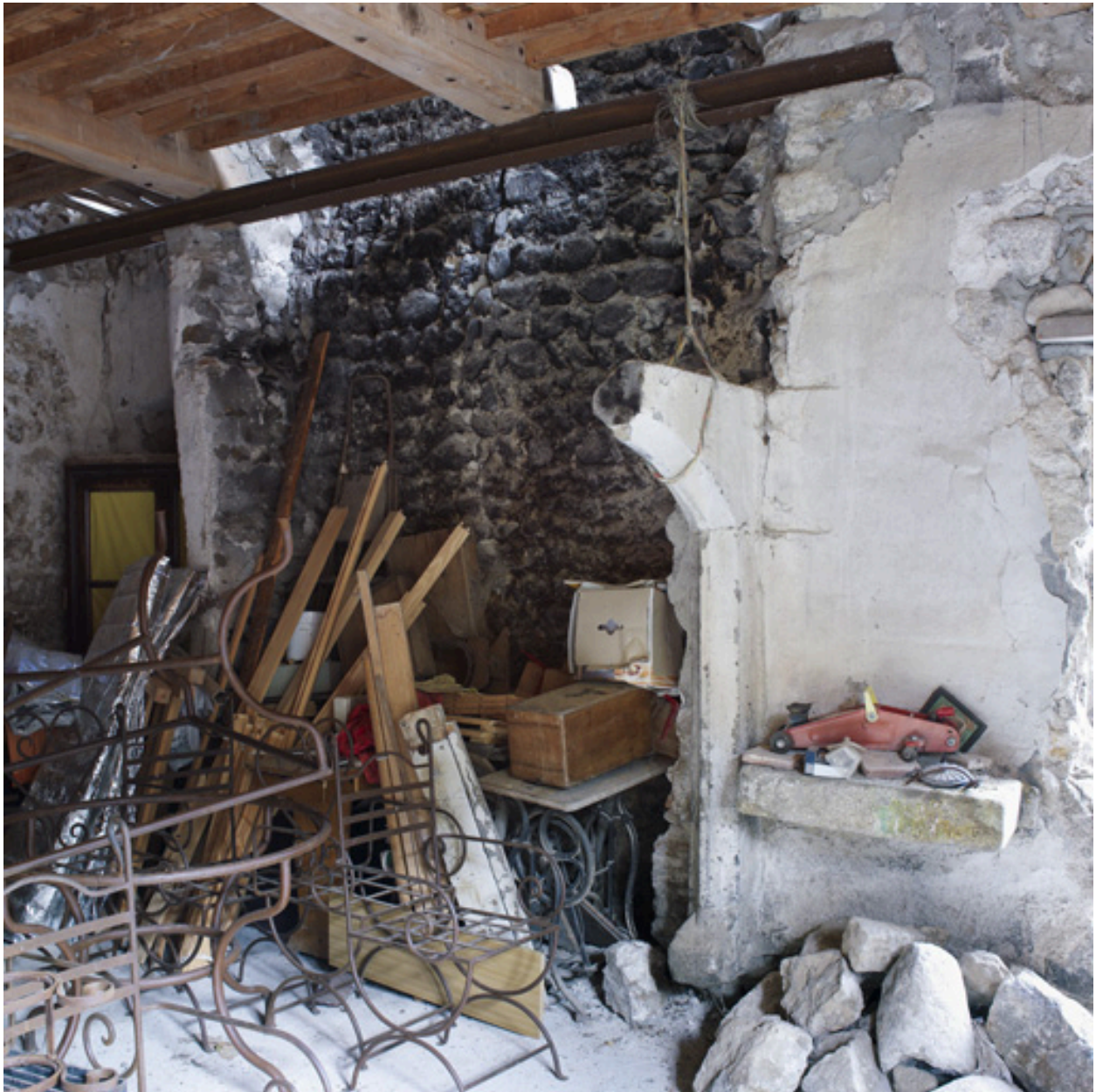
Vue intérieure de la salle au rez-de-chaussée surélevé : cheminée.
