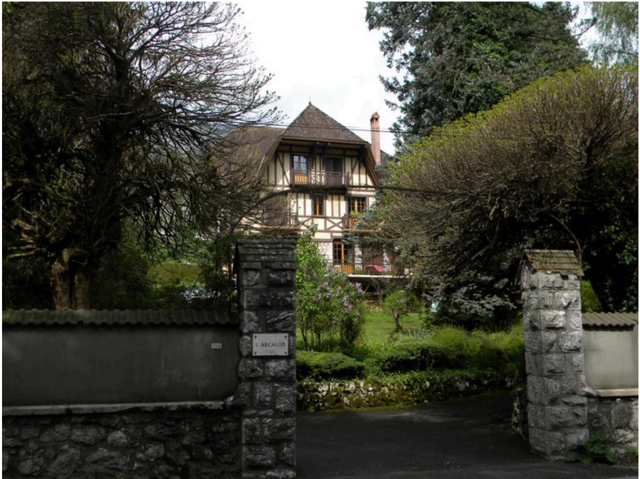
Vue d'ensemble depuis la route avec le porche d'entrée.
