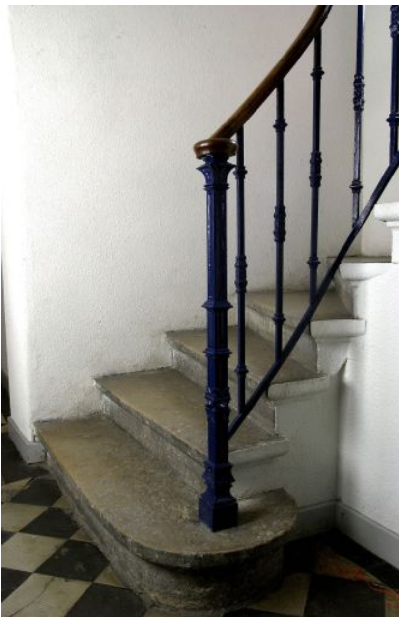
5 quai Rambaud. Rampe d'escalier en fonte
