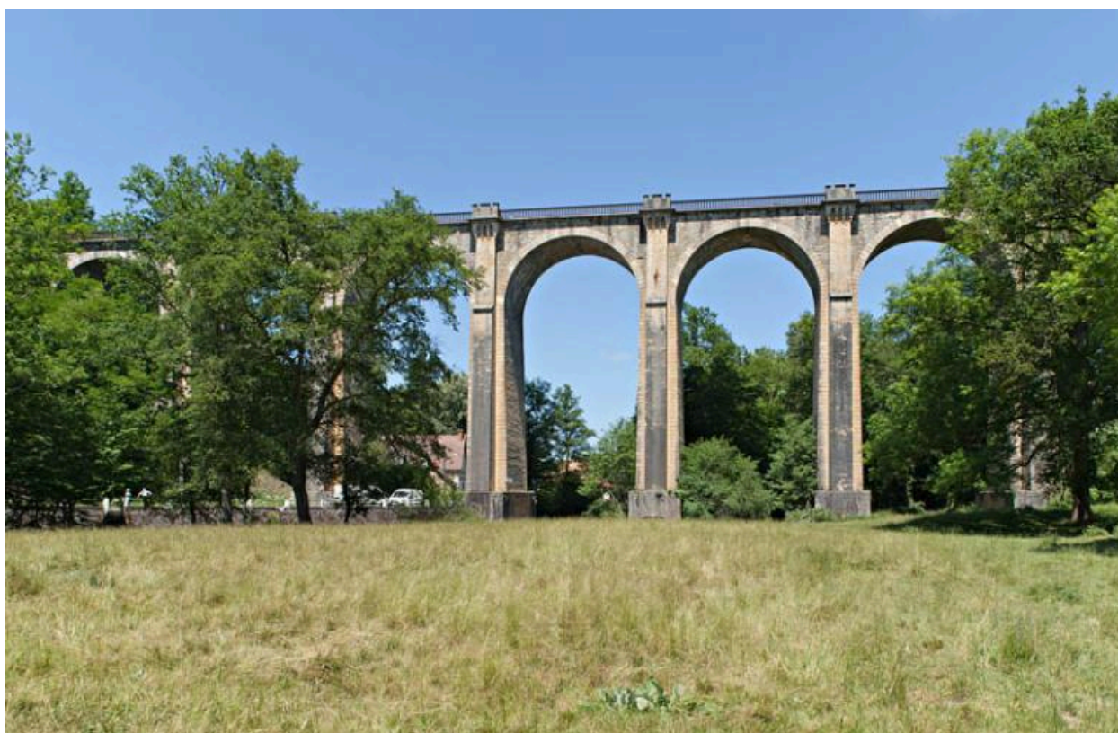
Vue générale du viaduc dans le site, depuis le sud.
