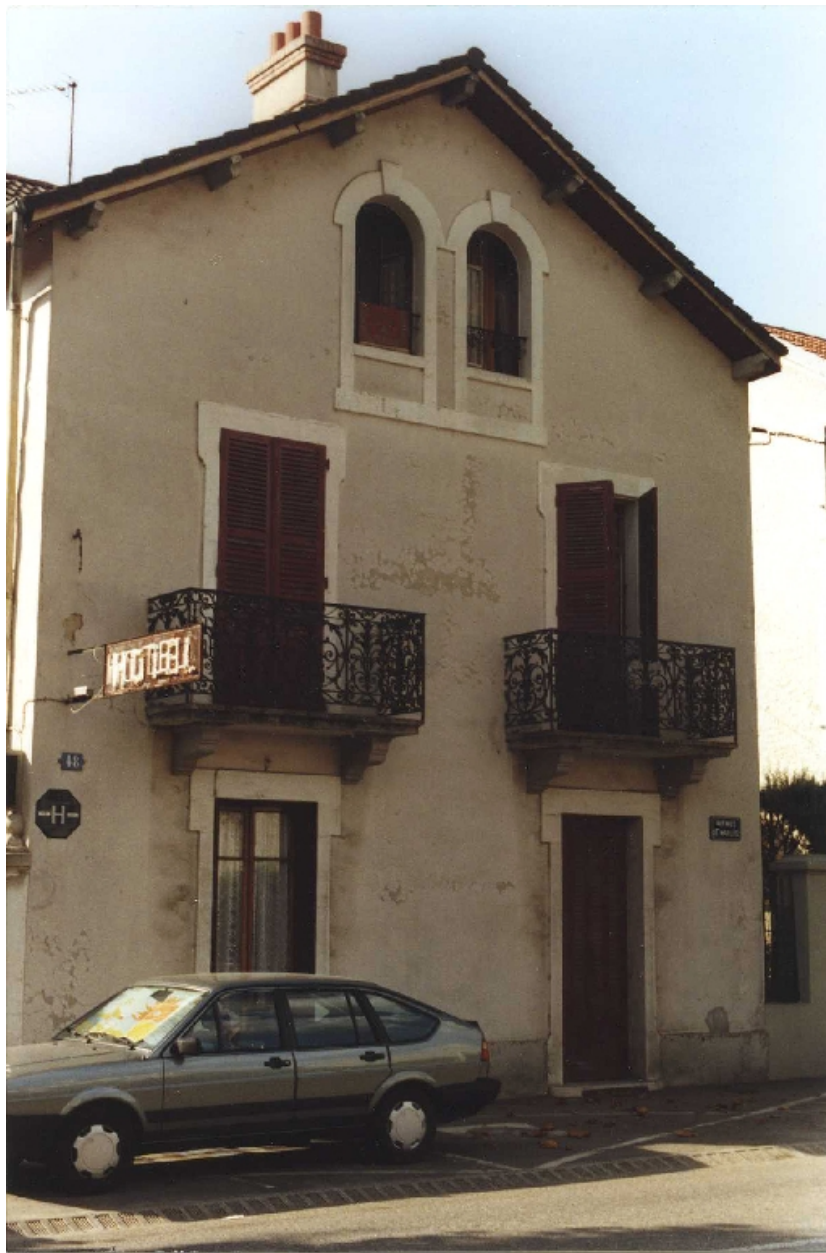
Façade est, avant démolition
