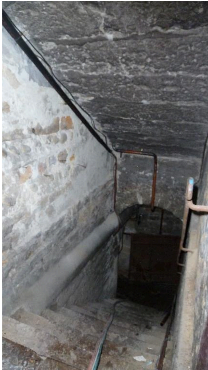
Vue de l'escalier menant à la cave depuis la cour
