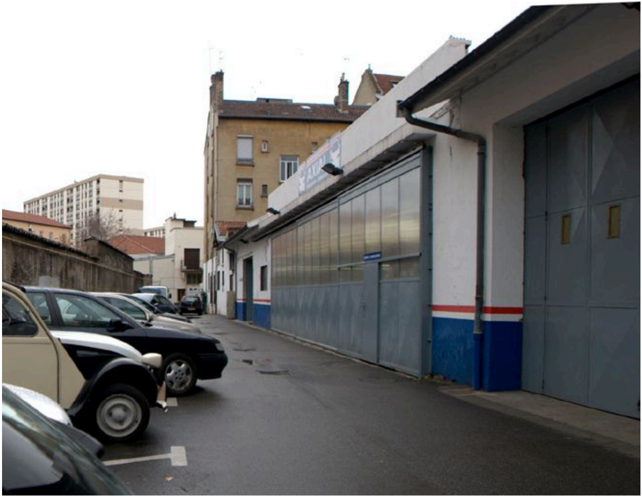
Vue générale des ateliers depuis le nord-est
