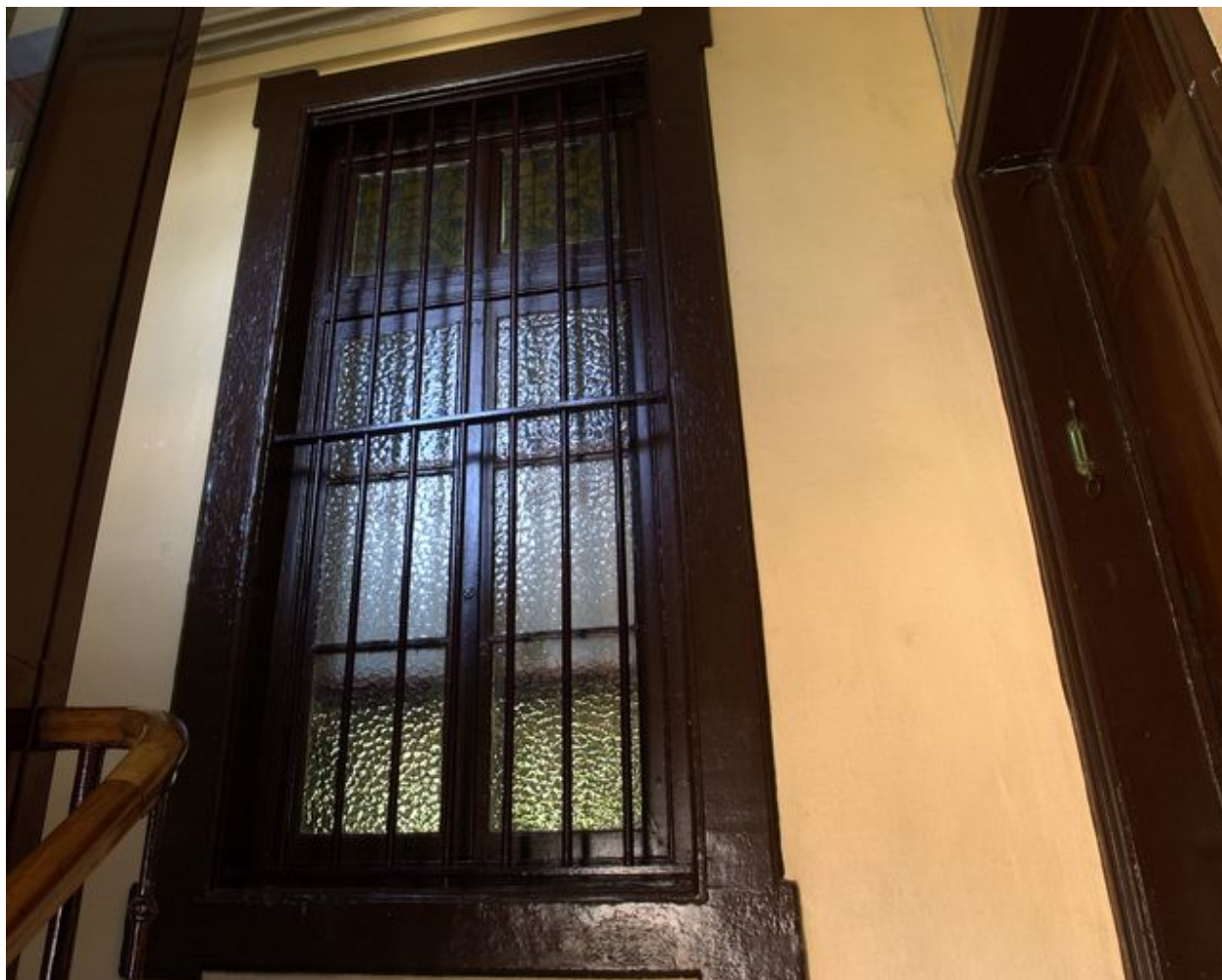
Fenêtre de second jour ouvrant sur la cage d'escalier
