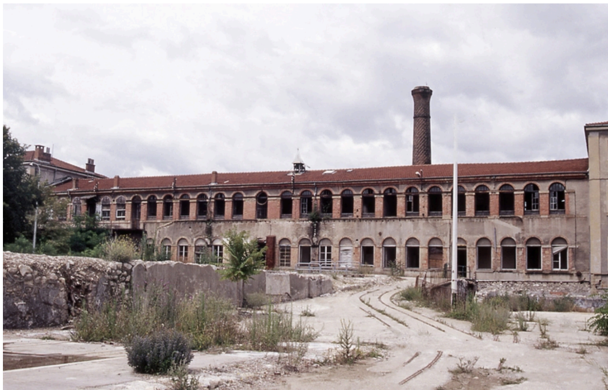
Vue d'ensemble est
