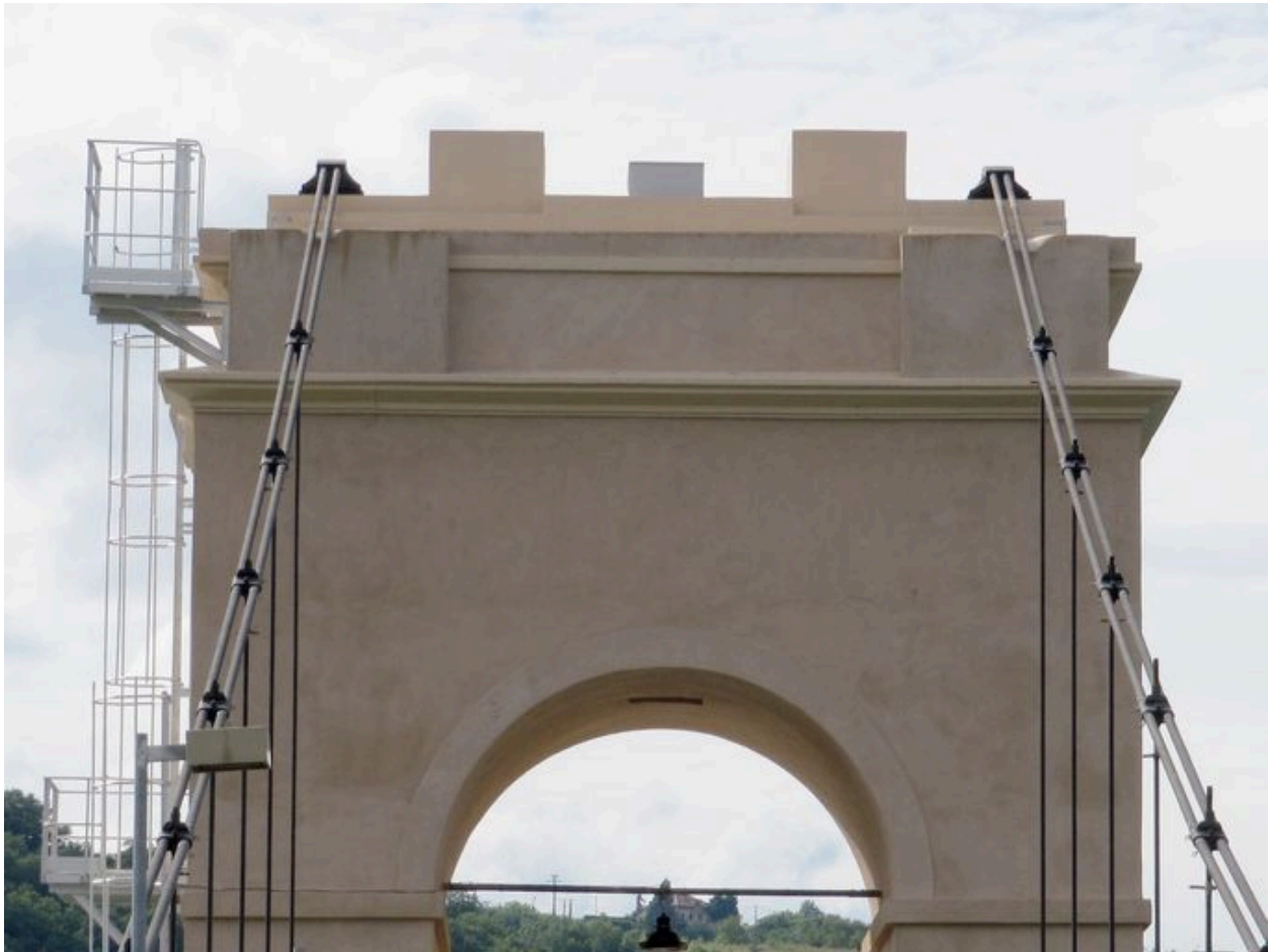
Pile centrale, vue partielle : passage des câbles porteurs au sommet (depuis la rive gauche)
