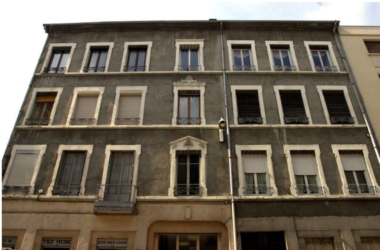
Détail de l'élévation sur rue
